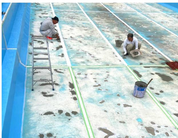
**老**朽化によるプール底面のコンクリートが剥がれが原因で、昨年度、水泳中に擦り傷などのケガをした人がいたことから、安全に水泳ができるよう、現在、高学年プール底面の修繕工事を行っています。また、低学年プールにもコンクリートが一部欠けているなど、素足で歩くと大変危険なことから、工事してもらっています。
